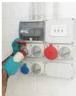
Collegare l'alimentazione elettrica motore trifase Fig.7
