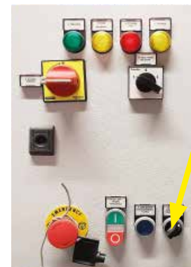
Con indicatore elettrico e contatore di particelle
