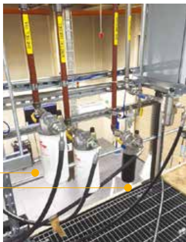
Filtro in linea LMP 210 e filtro Spin-On MPS per diesel, olio motore e fluido adblue
