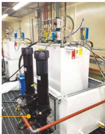
Centrale oleodinamica con filtro in linea duplex LMD 431
