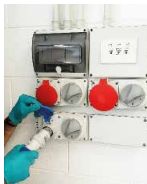
Fig.6 Collegare l'alimentazione elettrica motore monofase
