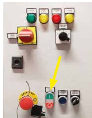
Con indicatore elettrico e contatore di particelle
