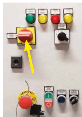
Con indicatore elettrico e contatore di particelle
