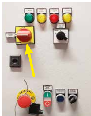
Con indicatore elettrico e contatore di particelle
