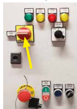
Con indicatore elettrico e contatore di particelle
