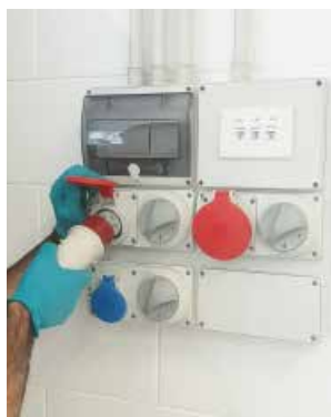
Fig.7 Collegamento elettrico per il motore trifase (spina 5 poli)
