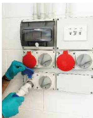
Collegare l'alimentazione elettrica
