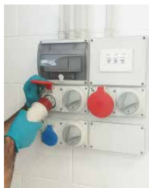
Collegare l'alimentazione elettrica motore trifase
