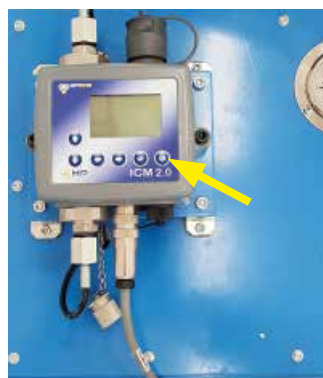
Attivazione manuale del conteggio delle particelle
