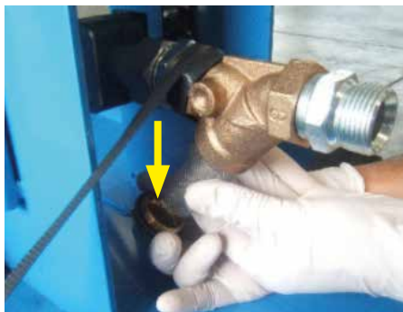
Svitare il dado e sfilare l'elemento filtrante
