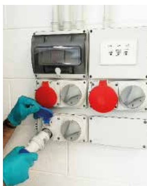
Collegare l'alimentazione elettrica motore monofase
